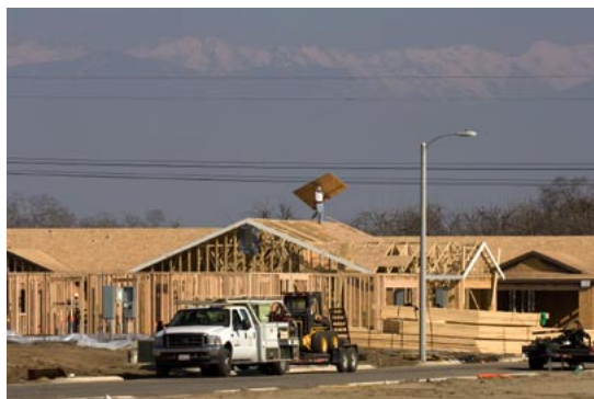
Housing construction near Visalia, California Construcción de viviendas cerca de Visalia, California
